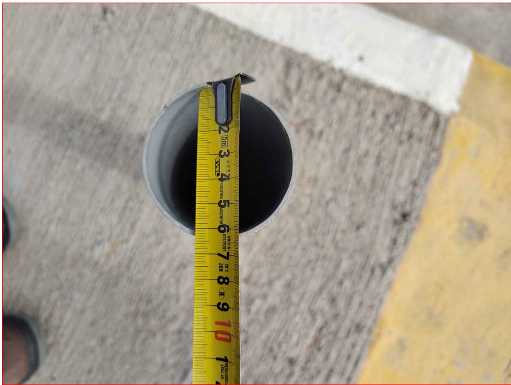
IMAGEN 3 - CAÑO DE PVC DE Ø63mm EMBUTIDO EN SEPARADOR
