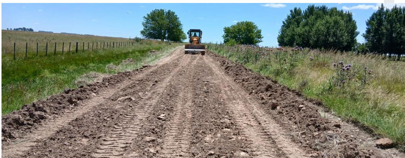
**MOTONIVELADORA 2:** Este equipo continuó con las tareas en el camino 78-2-27, desde La Granja hacia El trili, con el objetivo de ir desmontando el acopio realizado meses atrás, a fin de dar altura al terraplén y mejorar el escurrimiento del agua. Se espera continuar con estas tareas en la zona hasta lograr altear los puntos bajos. A su vez también se aportó material con la batea municipal.
