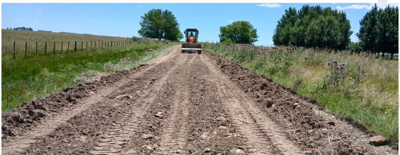
**MOTONIVELADORA 2:** Este equipo continuó con las tareas de bacheo en el camino 78-2-24 (Camino de La Liebre) en conjunto con la retroexcavadora municipal y un camión utilizado por intercambio de horas de equipo. Allí se está interviniendo solo en las partes que requieren de bacheo, aportando material de un acopio existente y de extracción lateral reciente. Se espera poder terminar las tareas la próxima semana y a su vez, dejar un acopio para futuras intervenciones.
