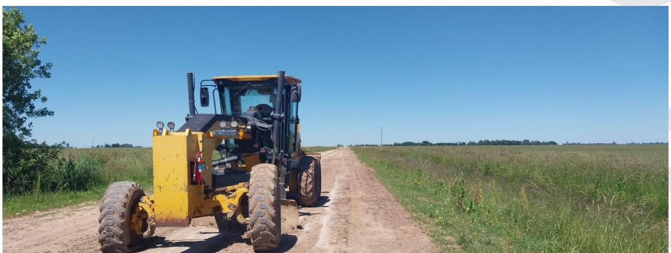
**MOTONIVELADORA 2:** Este equipo a lo largo de este periodo estuvo realizando tareas de reconformado en la zona próxima a L'Amalí y 16 de julio. Puntualmente en los caminos 78-2-35; 78-2-36; 78-2-37 y 78-2-37b. Allí se trabajó aportando material para sanear pantanos, y se continuó con las tareas ya iniciadas de aldeo, desparramando el material extraído desde las cunetas. Se espera seguir avanzando esta semana para mejorar la transitabilidad de la zona.
