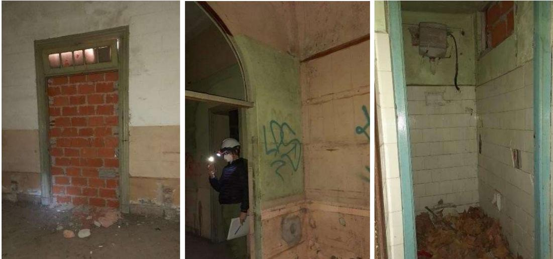
Carpinterías, muros y pinturas en mal estado, ausencia de cielorrasos, servicios obsoletos
